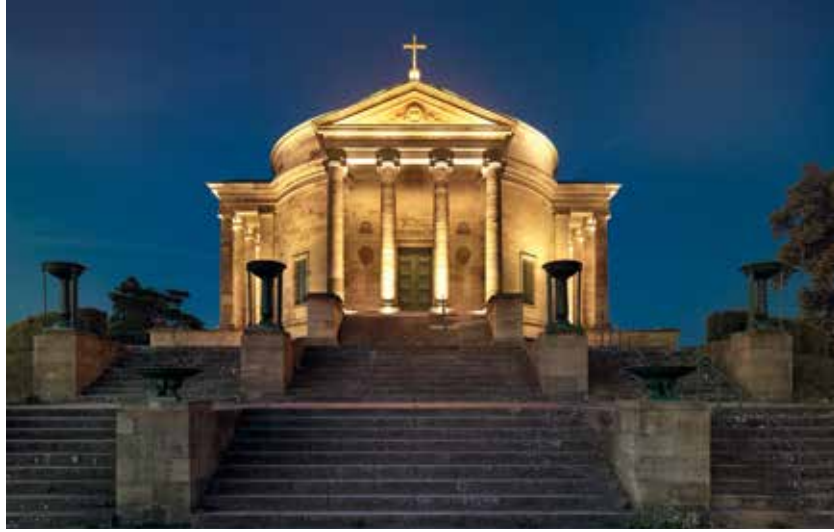
Grabkapelle Rotenberg in Stuttgart: Auch kleine Maßnahmen wie der Austausch der Beleuchtungskörper in LED tragen zu einer besseren CO 2 -Bilanz des Landes bei.
