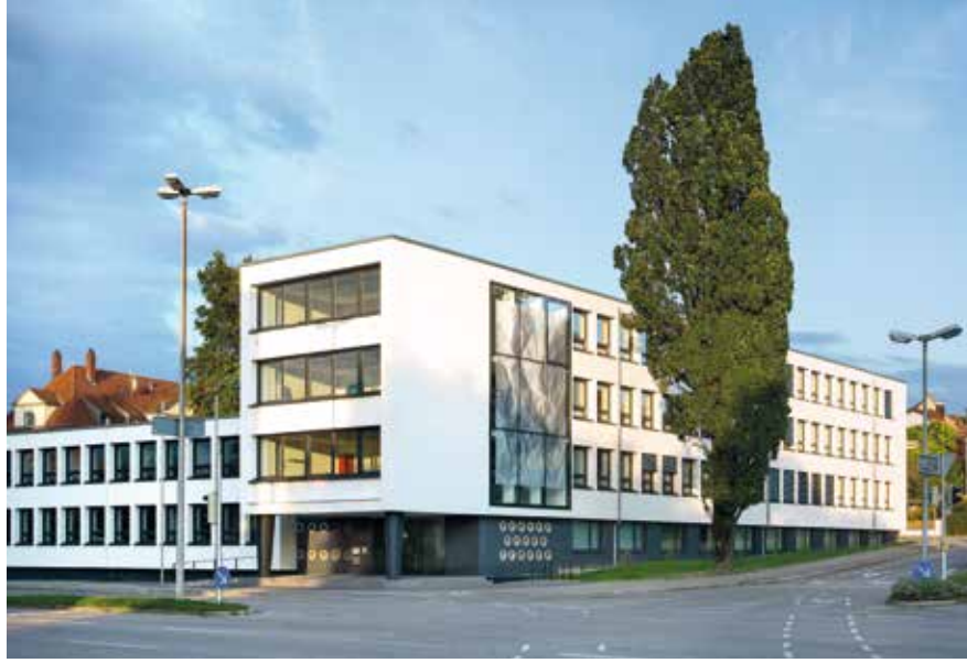
Grundbuchamt Ravensburg: Neben der energetischen Sanierung der Außenhülle wurde auch die Heizungsanlage erneuert. 80 Prozent des Wärmebedarfs werden zukünftig über Holz-Pellets gedeckt. Das spart rund 18 Tonnen CO 2 -Emissionen im Jahr.
