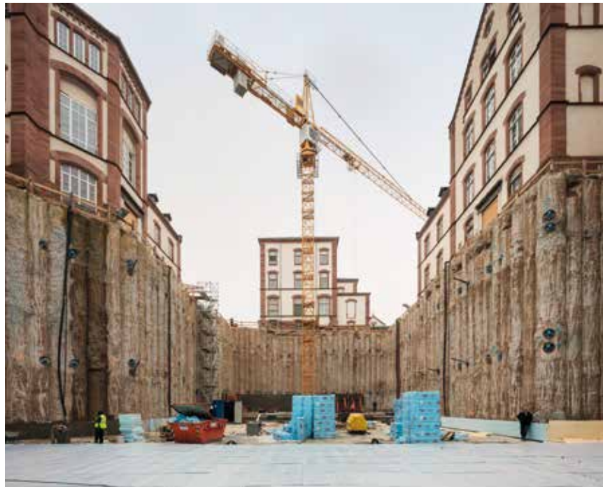
Centre for Asian and Transcultural Studies der Universität Heidelberg: Zur Herstellung des Neubaus der Bibliothek wurde eine 16 Meter tiefe Baugrube benötigt. In die Bewehrungskörbe sind Geothermieschläuche eingelegt. 65 Bohrpfähle sind aktiviert, Wasser dient als Wärmeträger.
